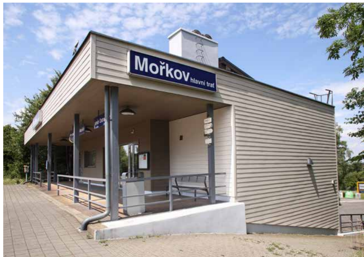
Hardie® Plank , horizontální montáž – barva: Štěrkově šedá a Espresso. Příklad fasády, kde původní dřevěný obklad po devíti letech od instalace zdegradoval natolik, že musel být kompletně vyměněn. Nádraží Mořkov, foto: Martin Kovář.
