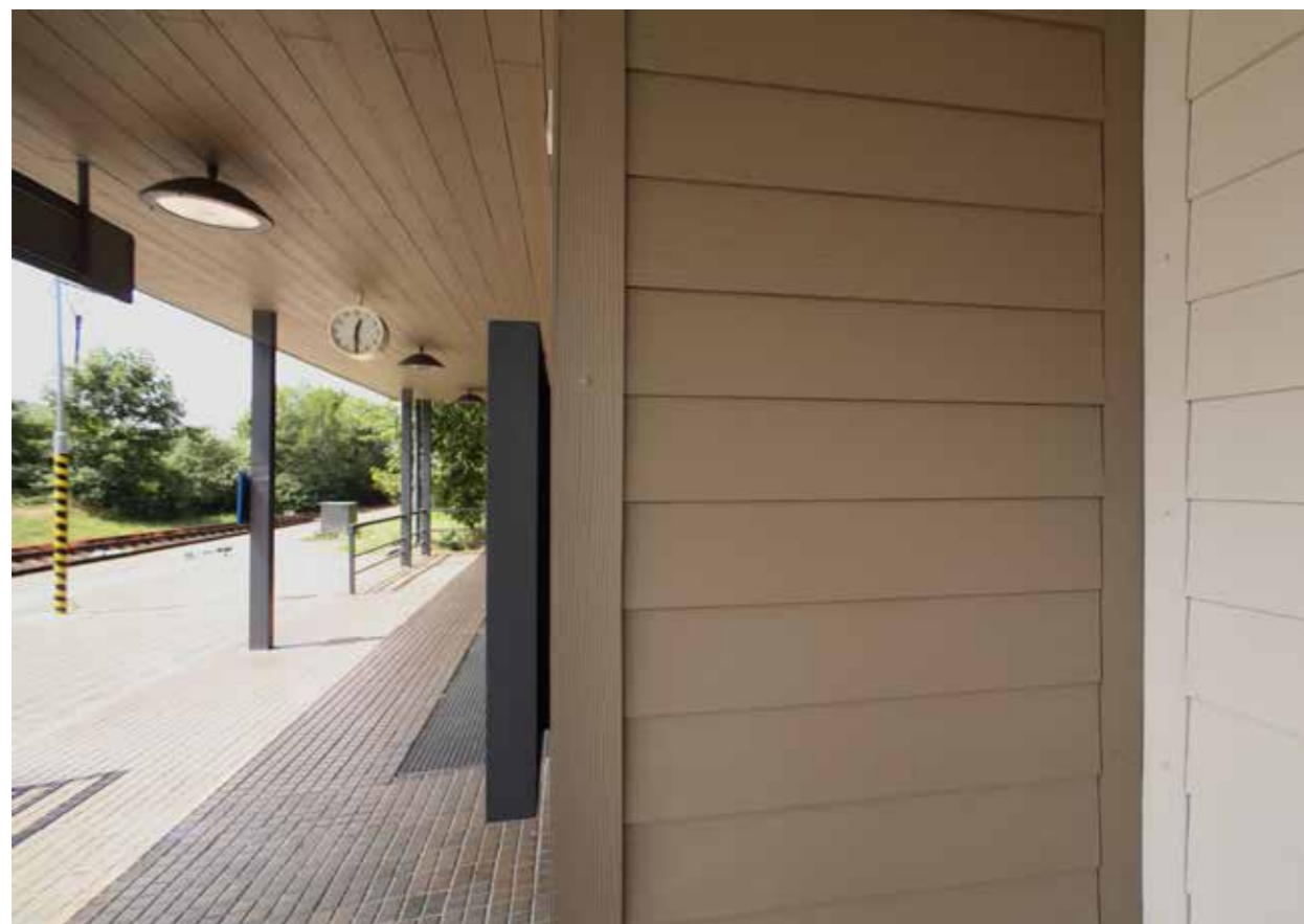
Hardie® Plank , horizontální montáž – barva: Štěrkově šedá a Espresso. Nádraží Mořkov, foto: Martin Kovář.
